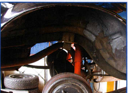
Die hinteren Radkästen und -läufe sind oft vom Rostfraß betroffen, Reparaturen schwierig
